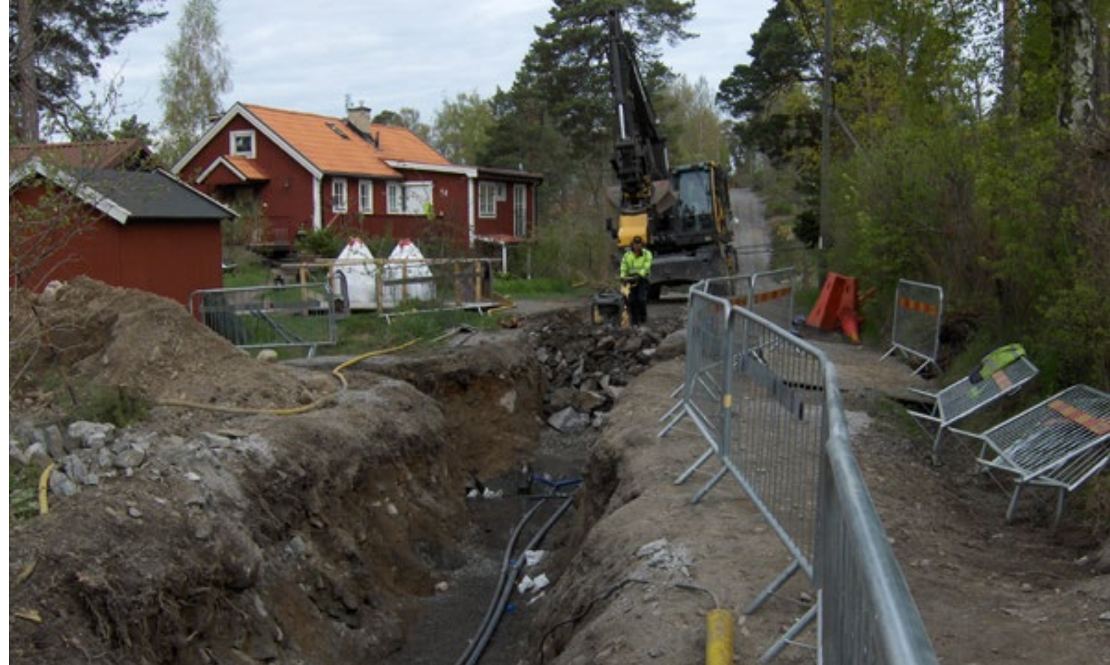
Grävarbete för vatten- och avlopp pågår
