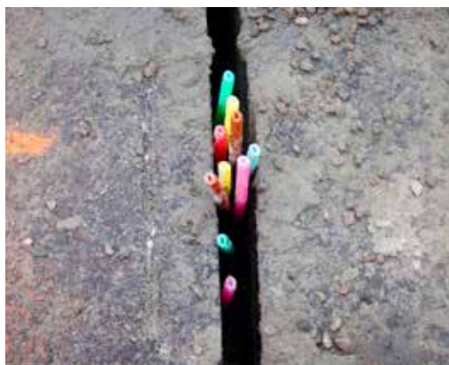
2. ... där kanalisation och fiberkabel läggs.
