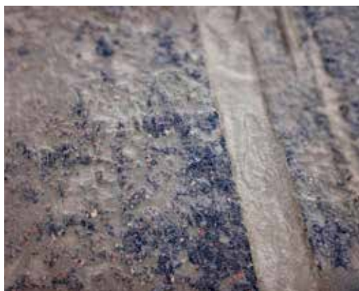
3. Skåran återfylls med skumbetong (bilden) och förseglas slutligen med gjutasfalt.
