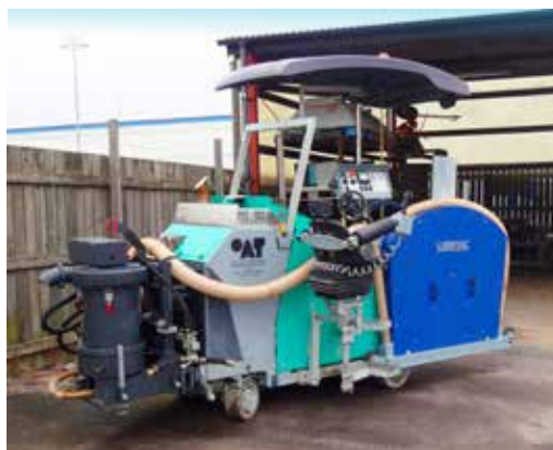
1. Den här specialmaskinen sågar upp en skåra i vägbanan...
