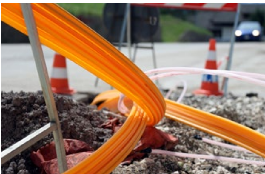
Se till att anlita certifierade företag som ska anlägga fiber för att ställa rätt krav och höja kvaliteten på arbetet. Robust Fiber har ett certifieringsprogram för företag som anlägger fiber. Foto: Mostphotos
